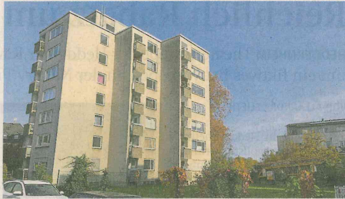
Fit für die Zukunft: Das achtgeschossige Gebäude in der Klauerstraße wird saniert. MATTHIAS BITTNER
